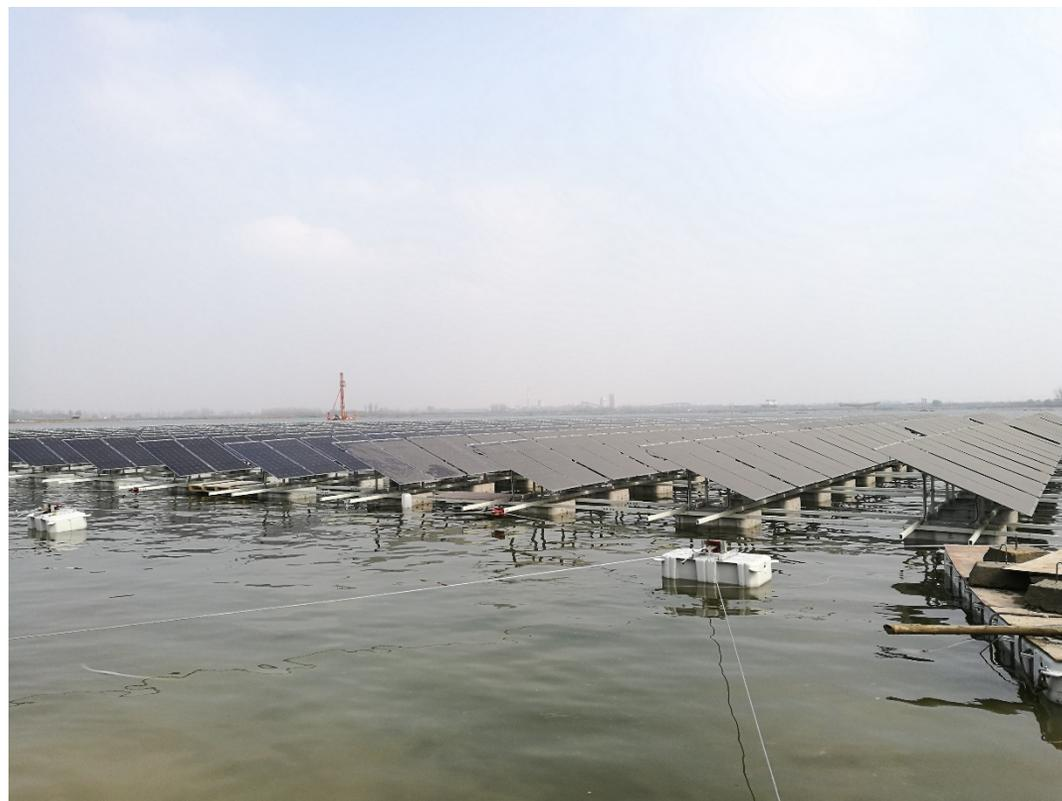
羲和专利超大水位变化自适应锚固连接系统：适应水深150米、水位变化25米以上深水库漂浮光伏电站。
